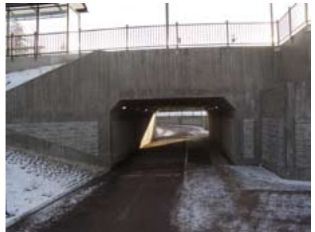
Som jämförelse: Järnvägsundergången för gång- och cykeltrafik vid stationen i Kolbäck, byggd 2006. Proportionerna mellan brobana och upplag obalanserade och brobanan inte skild från upplaget. Har mer karaktär av tunnelmynning i berg.
