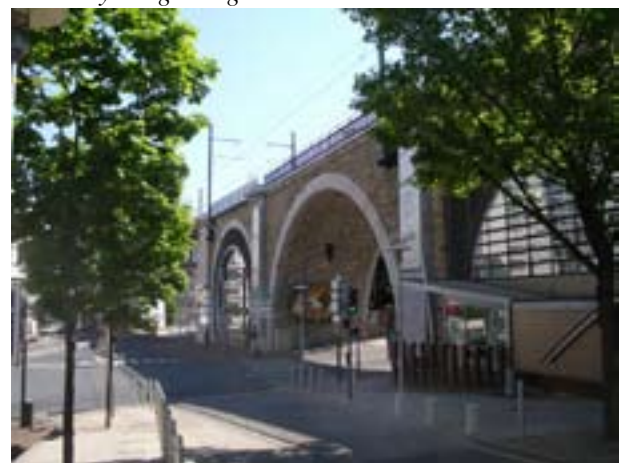
Järnvägsbro med underbyggnad för järnvägen till Versailles vid Issy i utkanten av Paris. Även här utnyttjas utrymmet under bron för butiker och kontor.
