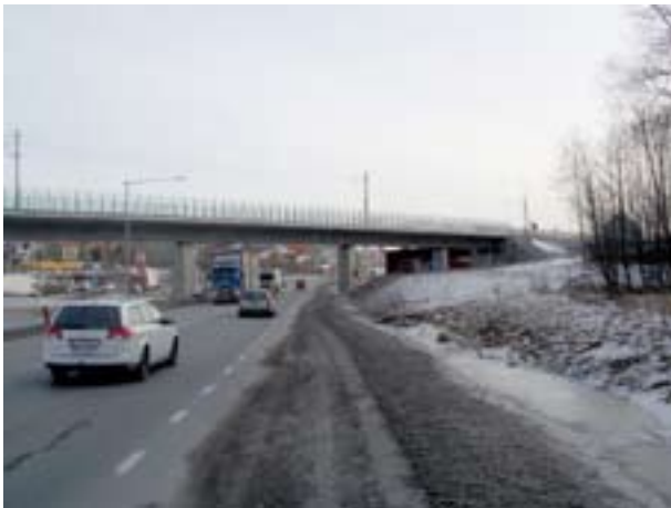
Järnvägsbro för Botniabanan vid södra E4-infarten till Örnsköldsvik, byggd under de senaste åren. Buller- och stänkskydd av glas gör att bron får ett slankt och lätt uttryck.
