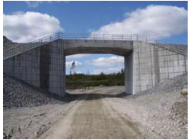
Järnvägsundergång för Ådalsbanan vid Veda söder om Kramfors, byggd 2008. Standardmodellen med vingar, men här med rusticering.
