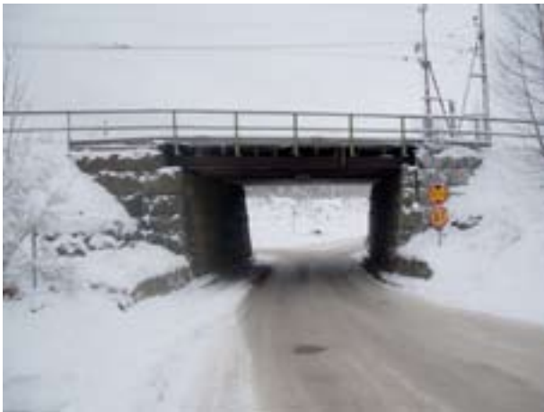
Järnvägsundergång från sent 1800-tal i Krylbo. Passagen har lagts strax söder om stationen där banvallen ligger några meter över omgivande marknivå. På fundament med naturstensbeklädning vilar en smäcker stålkonstruktion. Räckena är enkla och fortsätter en bit längs banvallen.
