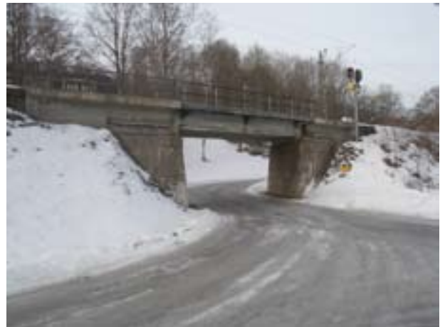
Järnvägsundergång under Ostkustbanan, nuvarande Ådalsbanan, i Skönvik norr om Sundsvall. Byggt på 1920-talet, sannolikt renoverat senare. Banvallen övergår i fundament med naturstensbeklädning som bär en relativt tunn brobana i betongkonstruktion. Det enkla skyddsräcket följer med tills brobanan landar i banvallen.
