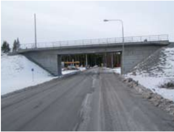
Järnvägsundergång för Botniabanan vid södra infarten till Hörnefors, byggd under 2008. Utformningen återknyter till det sena 1800-talets tydliga uppdelning mellan fundament och brobana. Fundamenten har även fått en rusticerande betongutformning som associerar till natursten.
