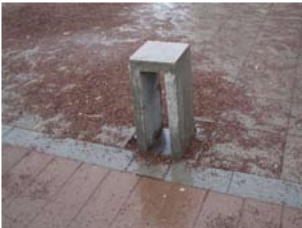
Jan Ejheds specialritade betongarmatur för stråket mot Långbryggan. Nederst i bilden de rödfärgade betongplanken i stråket.
