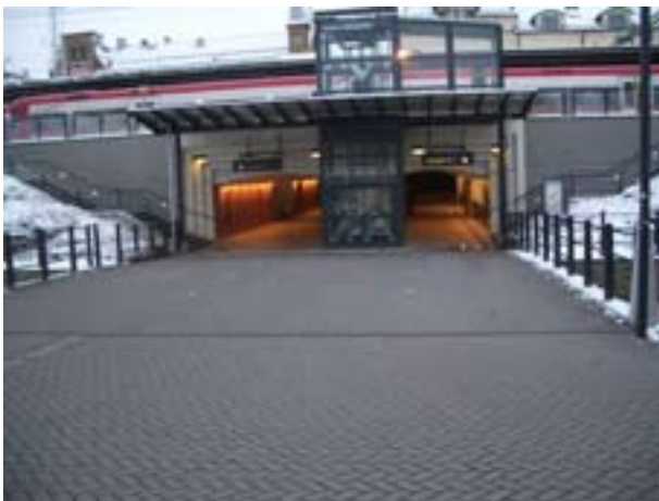
Järnvägsundergång för gångtrafik vid Gävle central, byggd 2005. Tunnelmynningen har trappats av för att upplevas mjukare och har försetts med ett tak som minskar känslan av hål i betongmur.
