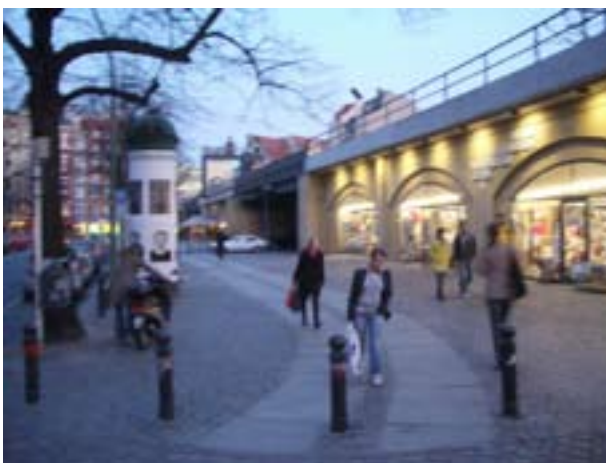
Järnvägsbro med underbyggnad för S-bahn vid Savignyplatz i Berlin. I tät stadsmiljö kan utrymmet under banan utnyttjas för butiker och verkstäder.
