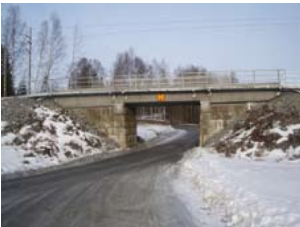
Järnvägsundergång under Ådalsbanan i Ramvik norr om Härnösand. Byggt på 1890-talet, uppenbarligen renoverat på senare tid. Banvallen övergår i fundament med naturstensbeklädning som bär en relativt tunn brobana i betongkonstruktion. Det enkla skyddsräcket följer med tills brobanan landar i banvallen.
