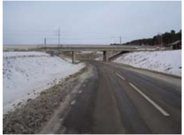
Järnvägsbro för Botniabanan vid Styrnäs norr om Kramfors, byggd under de senaste åren. Den öppna lösningen gör att vägläntan tydligt fortsätter bortom bron.
