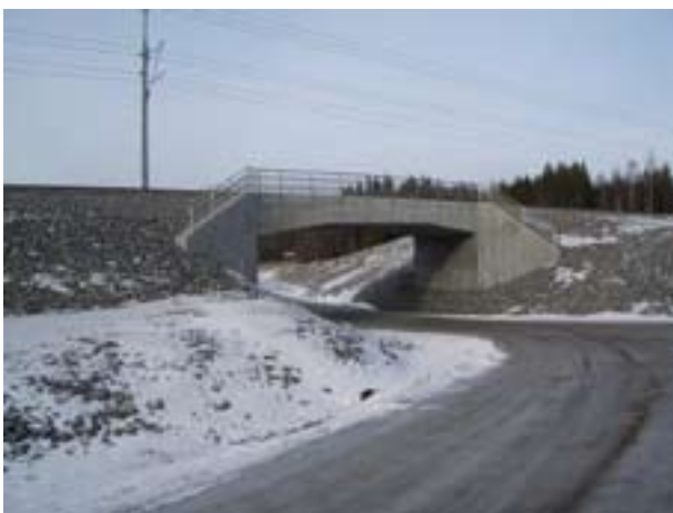
Järnvägsundergång under Botniabanan norr om Örnsköldsvik, byggd under de senaste åren. Den bärande brodelen är integrerad med fundamenten och saknar här markering av brobanan. Den vanliga vingformen med sina tre skydds-räcken tycks ha blivit standardlösning.
