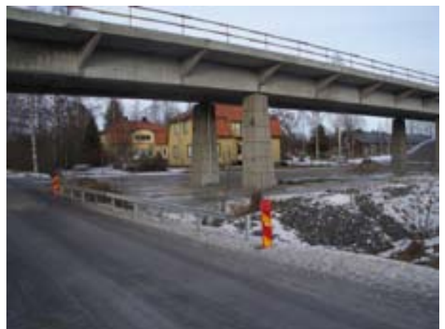
Järnvägsbro för Botniabanan genom Hörnefors söder om Umeå, under byggnad 2008. Kulturmiljön kring det gamla bruket krävde särskild brouthformning som fått industrihistoriska drag.
