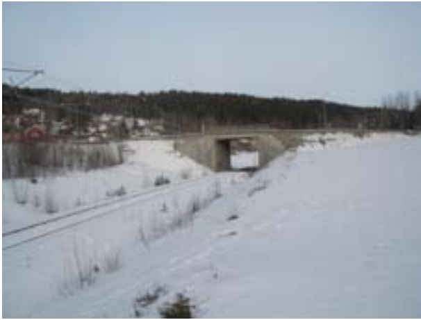
Vägbro över Ådalsbanan i Kramfors, byggd på 1980-talet. En vanligt förekommande modell med utvikta vingar av betong som ökar intrycket av tung konstruktion och delar upp vägläntan i två partier och kräver skydds-räcken både längs vägbanan och de utvikta vingarna.
