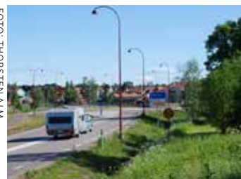
Söder om Karlsviks rondellen är slänterna Trafikverkets ansvar. Likaså väster om riksvägen mellan Karlsvik och Vasagatan.
