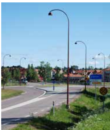
Riksvägen: Thorn Victor. Stolphöjden trappas successivt ner mot centrum.
